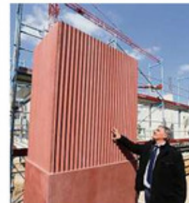
Lothar Hein am Beton-Musterteil.
